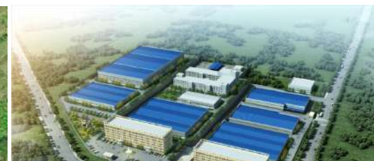
九州通博山制药新药制剂项目
