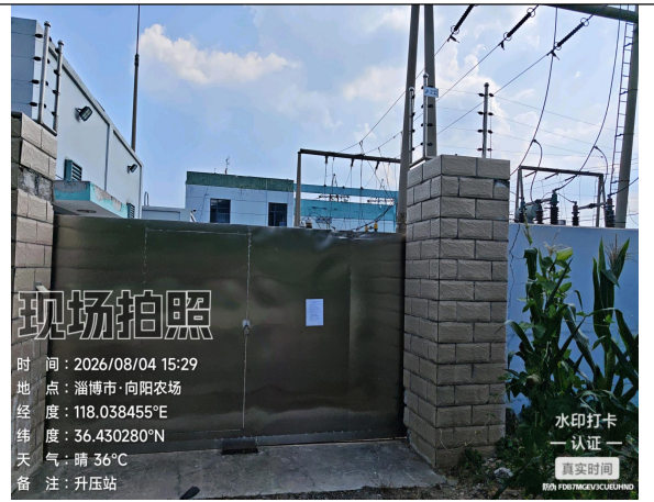
升压站第十工作日张贴内容
