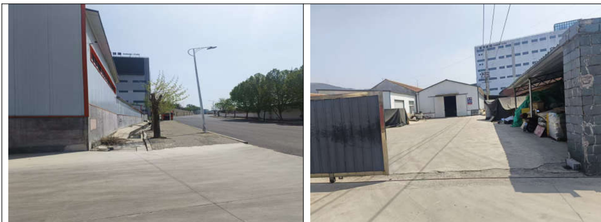
项目厂区南侧道路
