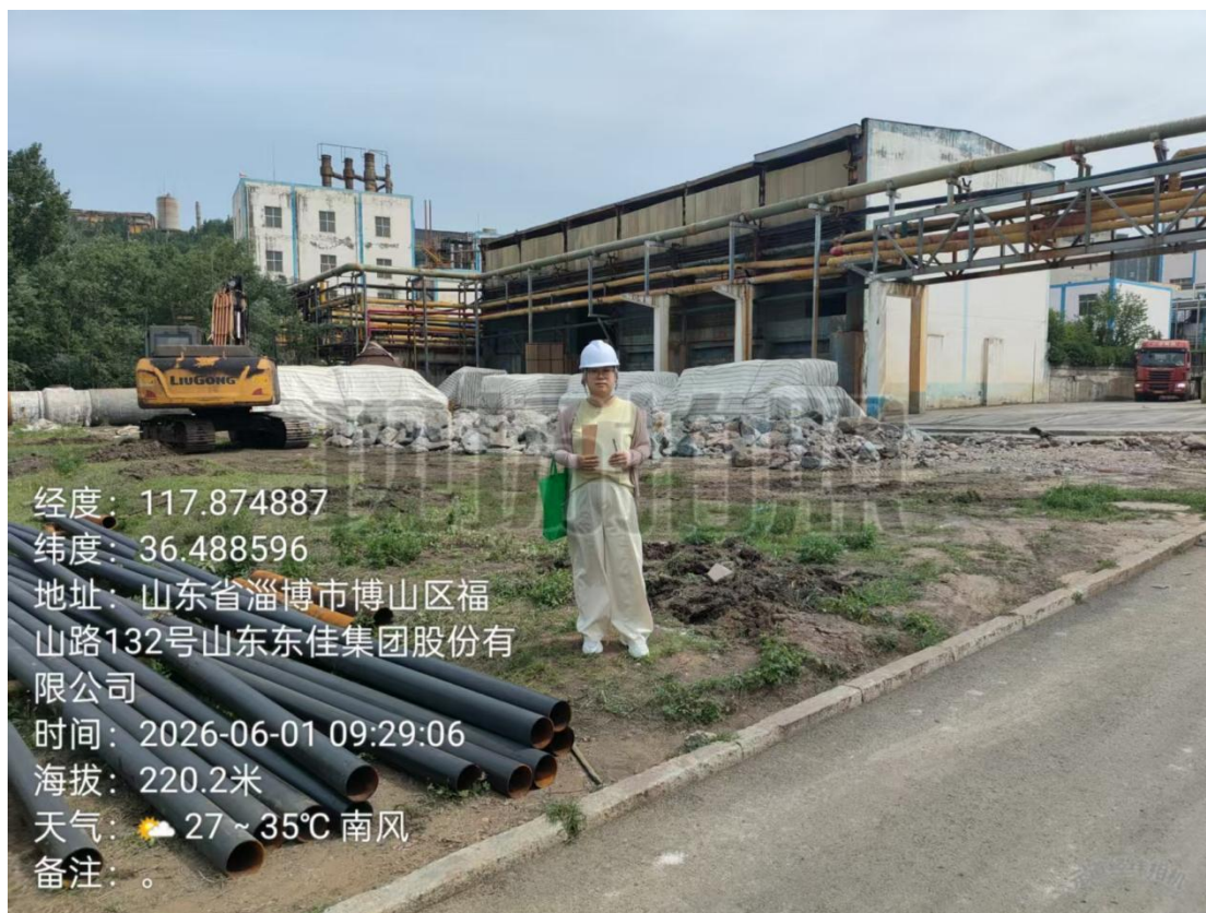
工程师现场勘察
