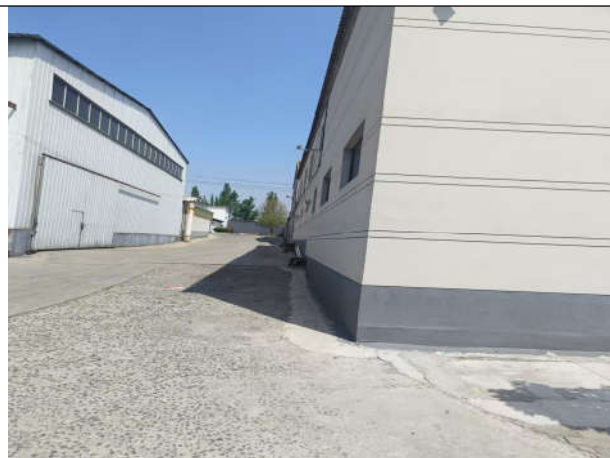
项目厂区西侧道路
