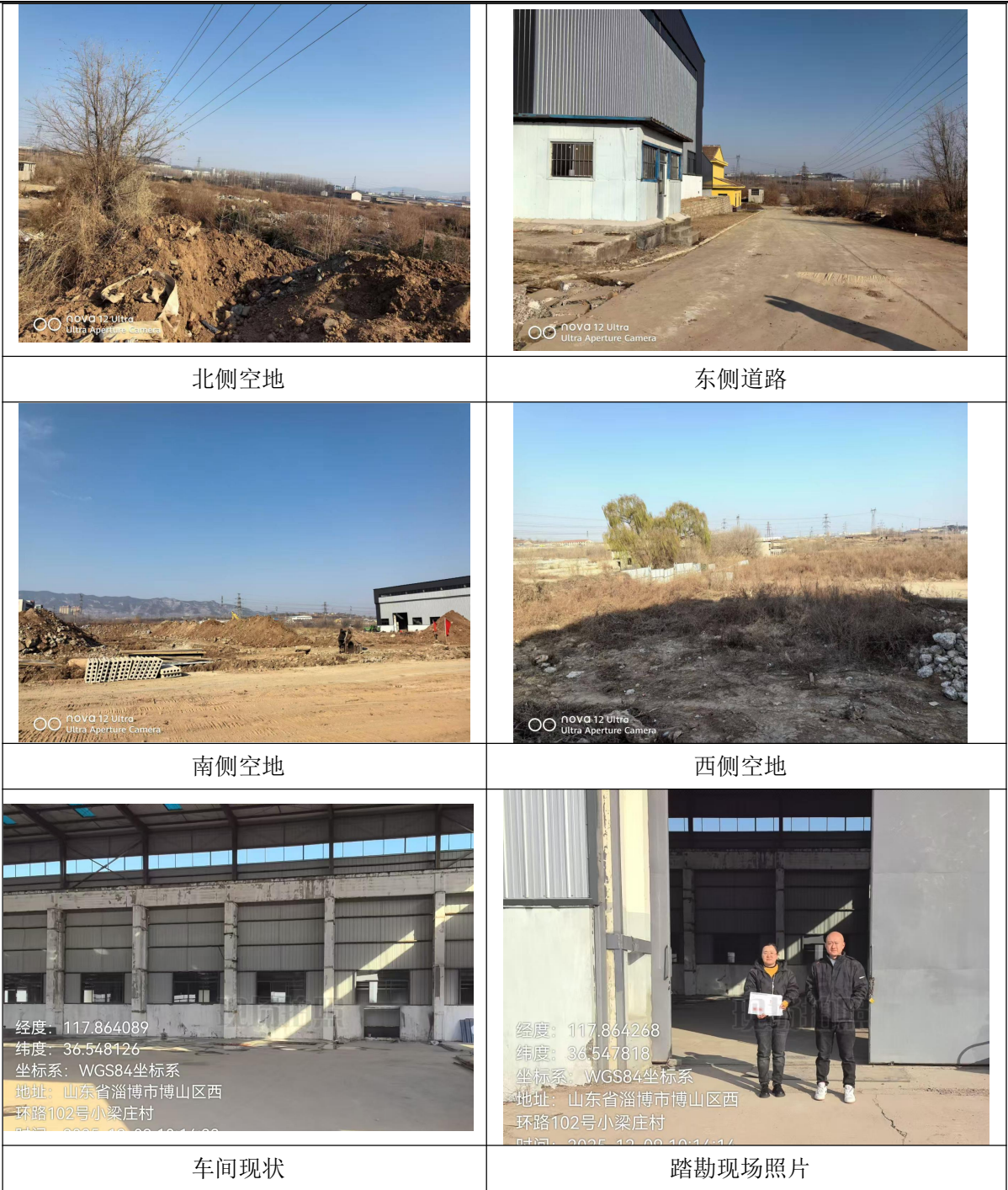
图 2-5 现场及周边情况照片
