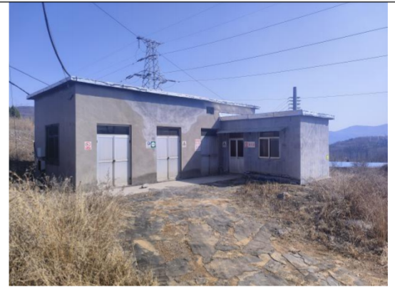
大黑山后村东南侧变电站值班室
