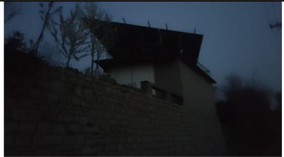
苏家沟村东侧沿街民房 2
