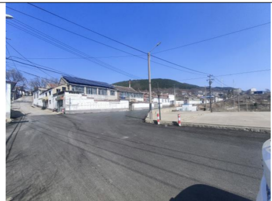
苏家沟村北侧沿街厂房 (2)
