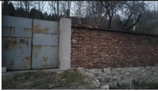
苏家沟村东侧沿街民房 1
