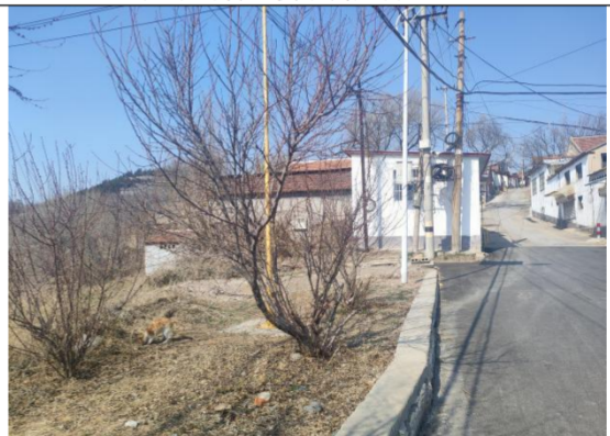
苏家沟村北侧沿街厂房 (3)
